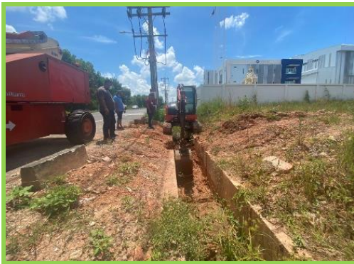
รูปที่ 2 การขุดลอกท่อระบายน้ำเสียและรางระบายน้ำฝนและบ่อฝัง
